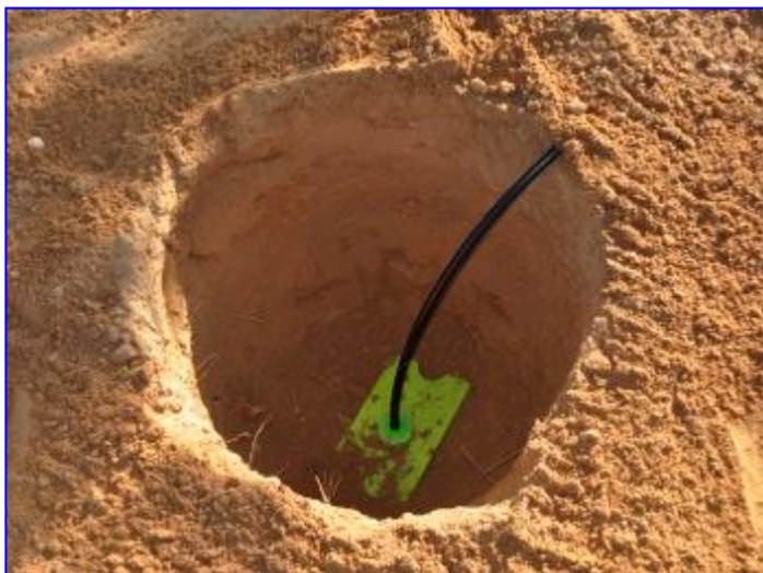
Diffuseur mis dans son trou (avant son enterrement) avec son tuyau vertical 16mm
