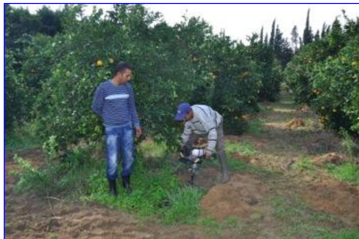
Installation des diffuseurs enterrés pour les orangers d'une exploitation à Beni Khalled, Cap Bon Nord de la Tunisie
